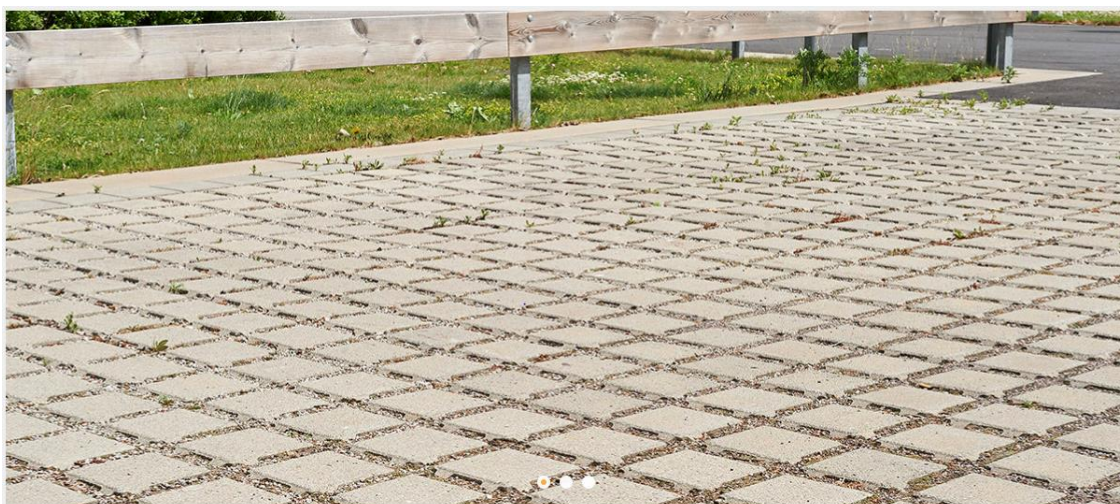
Figur 13. Exempel på genomsläpplig beläggning av p-yta 15 .
